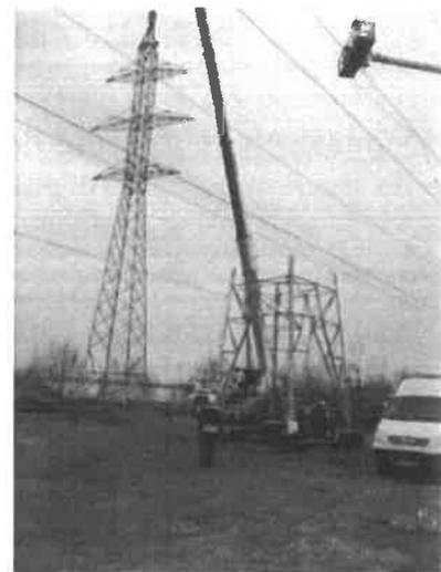
La partie basse du support (le fût) est assemblée au sol et levée à l'aide d'une grue, puis la partie haute (la tête) est assemblée et équipée des chaînes d'isolateurs et levée à l'aide d'une grue également.
