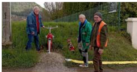
Contrôle des poteaux incendie.
