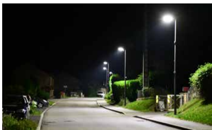
Passage en LED de l'éclairage public, rues du Jard et de Sainte-Odile.
