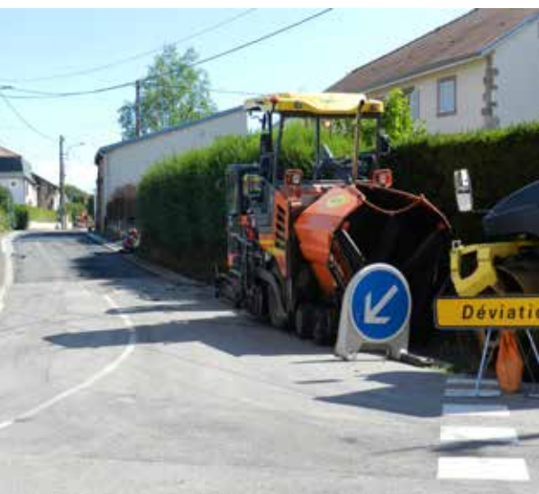
Changement des canalisations du pluvial, des caniveaux, et pose d'enrobé rue des Déportés
