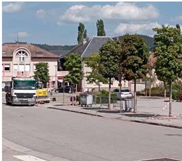
Travaux d'éclairage public place Abbatale
