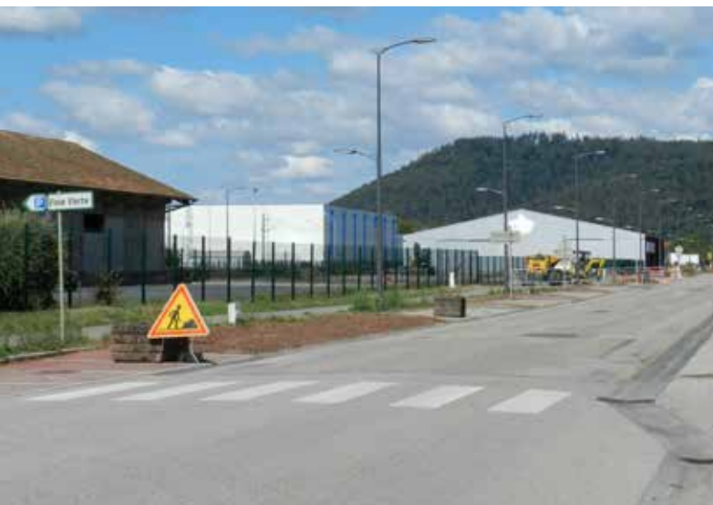
Deuxième tranche des travaux de viabilisation des terrains avenue Charles de Gaulle
