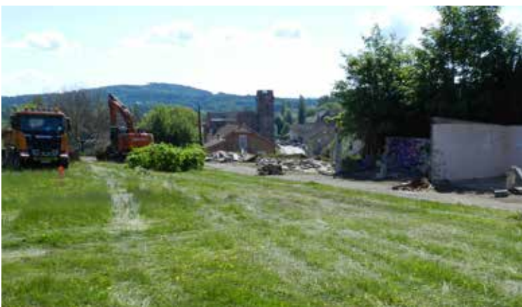
Préparation du terrain pour la nouvelle école
