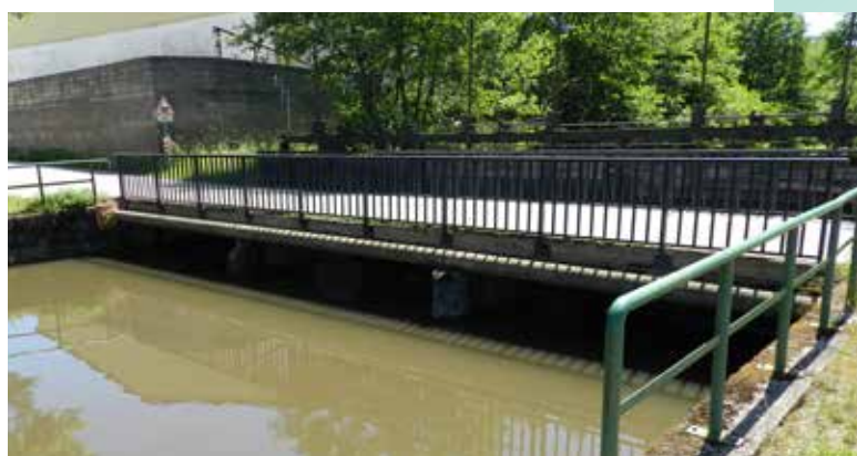
Remplacement du garde-corps du pont du canal des Papeteries
