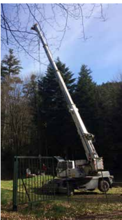
Changement préventif de la pompe du forage de Beaulieu permettant avec les sources de la Chipotte, d'alimenter en eau potable la commune. D'importants moyens ont été déployés pour remplacer cette pompe implantée au fond du forage... à 110 mètres.
