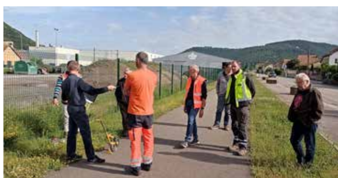
Viabilisation de la deuxième tranche entre le local TMF et le parking de covoiturage. Installation future des entreprises SP Garage et Pro Tech Piscine.
