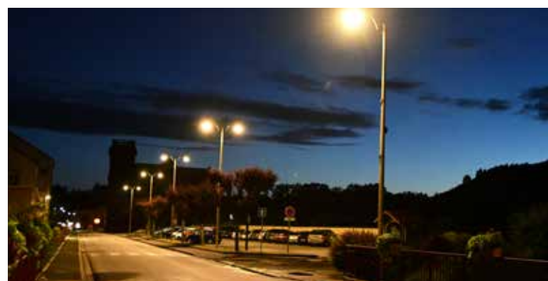
Passage en LED de l'éclairage public, rue de l'Abbaye
