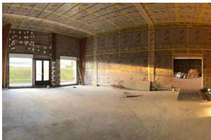
Réfection de la salle polyvalente et création de la nouvelle cantine
