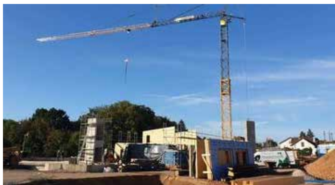
Avancement des travaux de la nouvelle école : montage des murs
