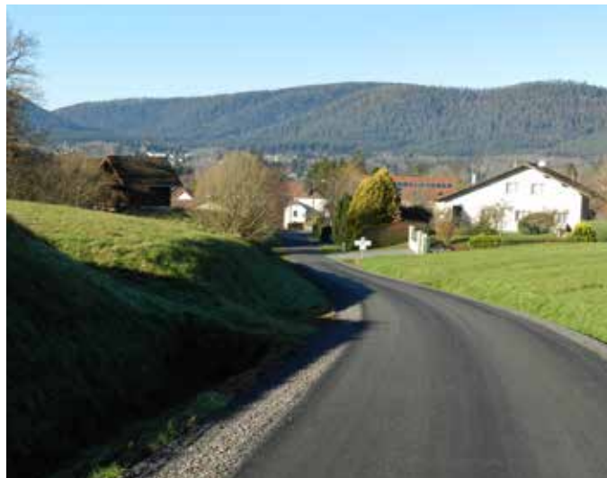
Réfection de la chaussée, rue de la Corvée
