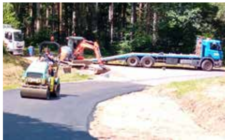
Réfection de la chaussée route du petit Himbeaumont
