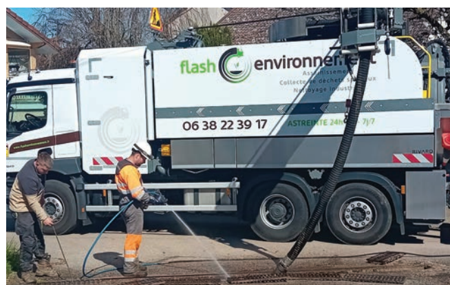
Opération de curage des réseaux de collecte des eaux pluviales.
