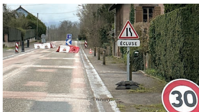
Mesure expérimentale d'un ralentisseur de vitesse dans le cadre des travaux de réfection de l'avenue de Bellefontaine.
